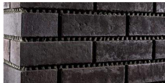
Полностью облицованная поверхность. После времени выдержки можно приступить к расшивке швов.
