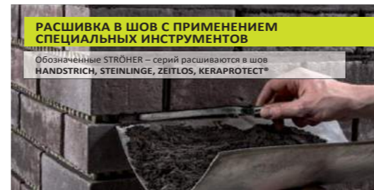
Расшивка с помощью мастерка для расшивки швов в горизонталях.
